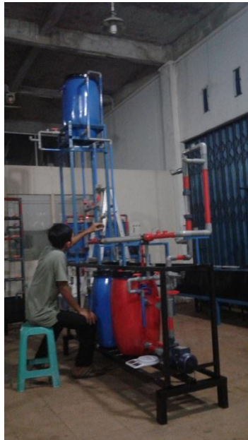
cek kebocoran instalasi
