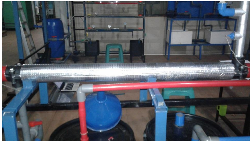
Pemasangan Isolasi pada Alat Penukar Kalor
