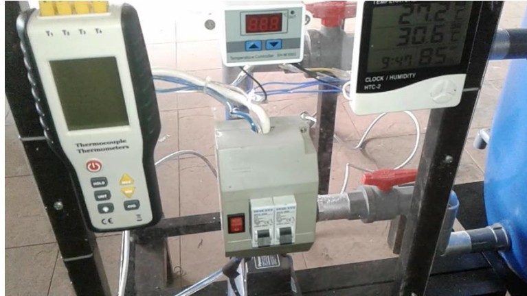
Pemasangan Panel Kontrol
