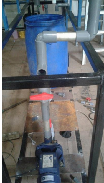
Pemasangan Pompa
