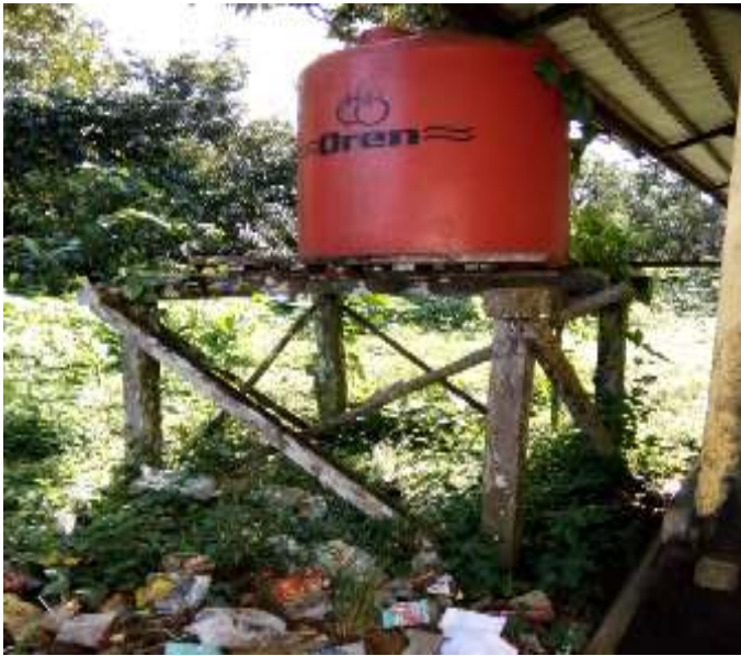
1.Sarana Penyediaan Air Bersih
