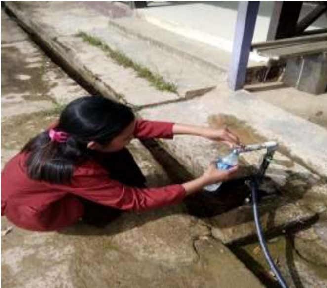
1. Sarana penyediaan air bersih
