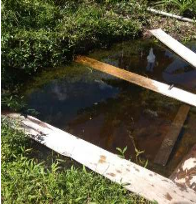
1. Sarana Penyediaan Air Bersih
