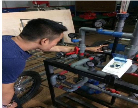
Mencatat Hasil Tekanan Air Yang Ada Di Manometer Analog.
