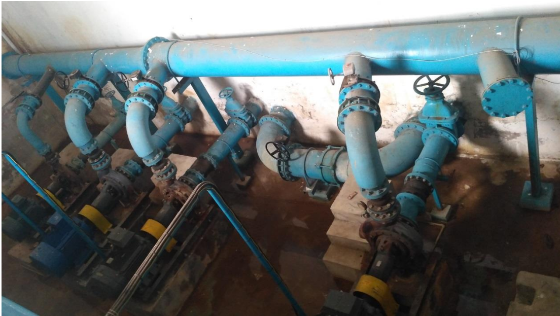
Gambar 1.1. Booster Pump Sepakat 2 A. Yani.
