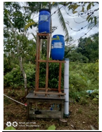
Bangunan Filter Air Gambut
