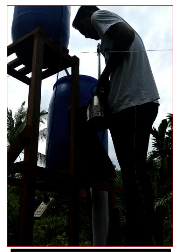
Memasang mesin Aerasi
