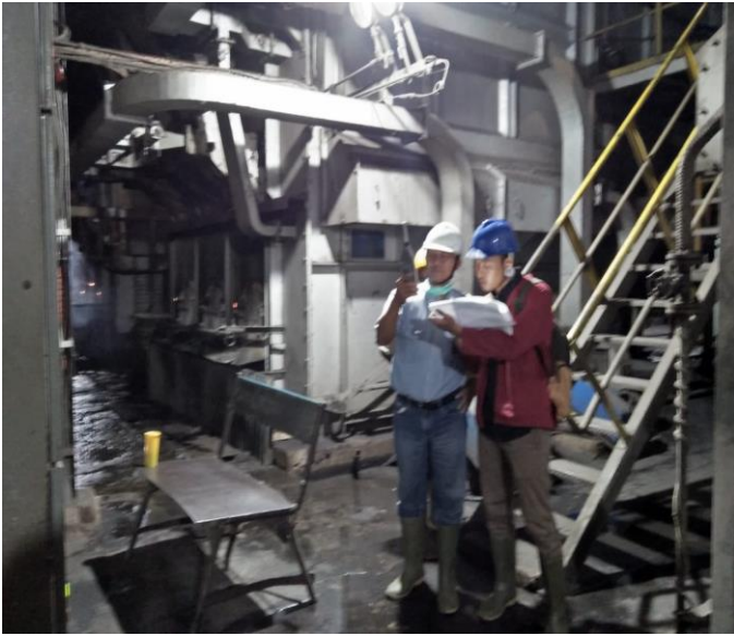
Pengukuran Kebisingan di Area Boiler
