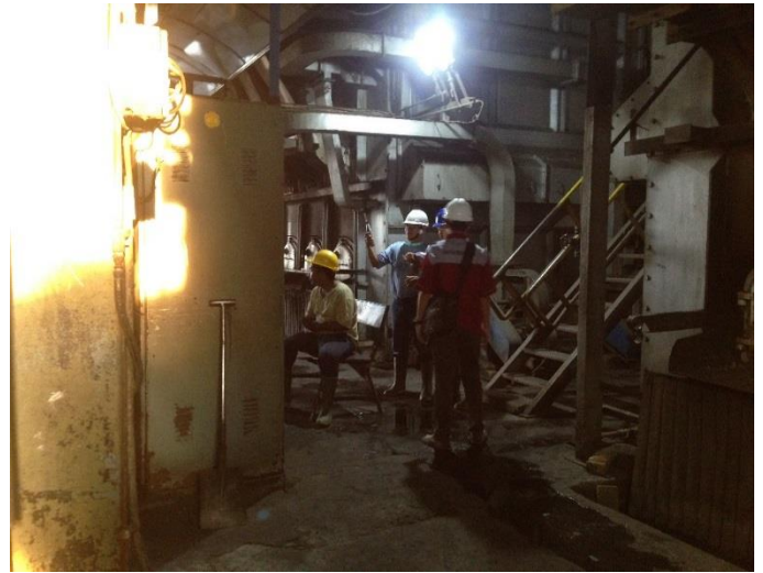
Pengukuran Kebisingan di Area Boiler
