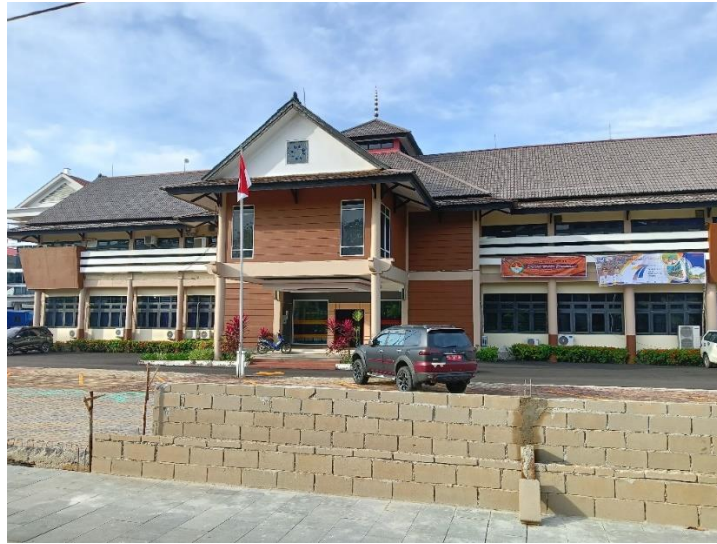
Foto kantor Dinas Pekerjaan Umum dan Penataan Ruang Kalimantan Barat yang beralamat di Jalan Ahmad Yani No. 252, Bansir Darat, Kecamatan Kota Pontianak Tenggara.
