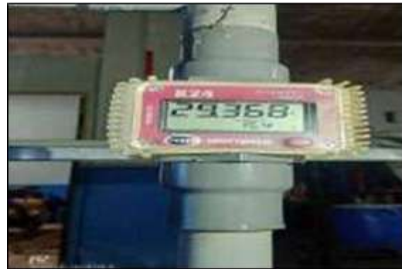
Gambar 5. Pemasangan Turbine Flow meter
