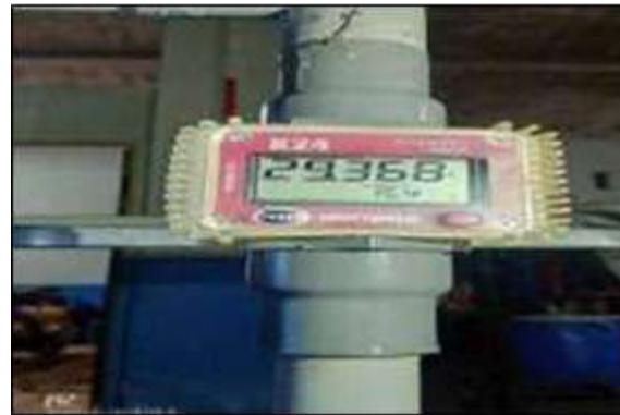
Gambar 5. Pemasangan Turbine Flow meter
