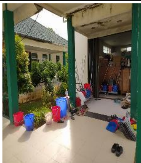
Foto 2 Gudang Penyimpanan Alat dan Bahan Kerja
