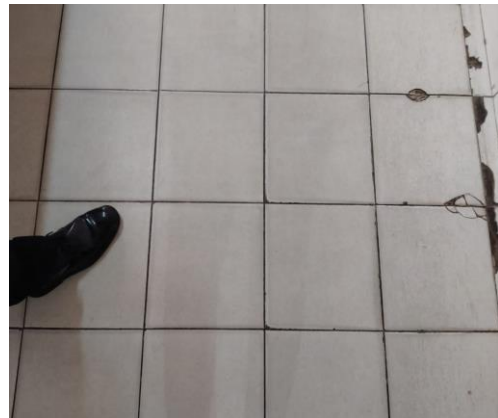
(Kondisi Lantai Instalasi Keperawatan)
