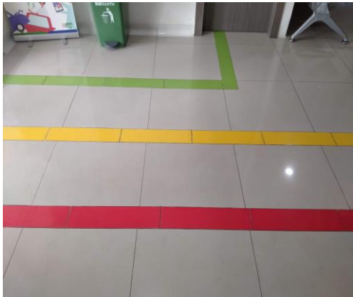
(Kondisi Lantai Instalasi UGD)
