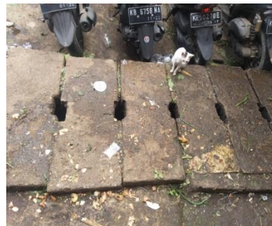
Gambar V. 9 Saluran Pembuangan Air Limbah Tertutup
