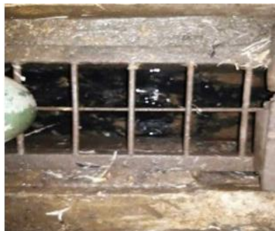
Gambar V. 8 Saluran Pembuangan Air Limbah Terbuka
